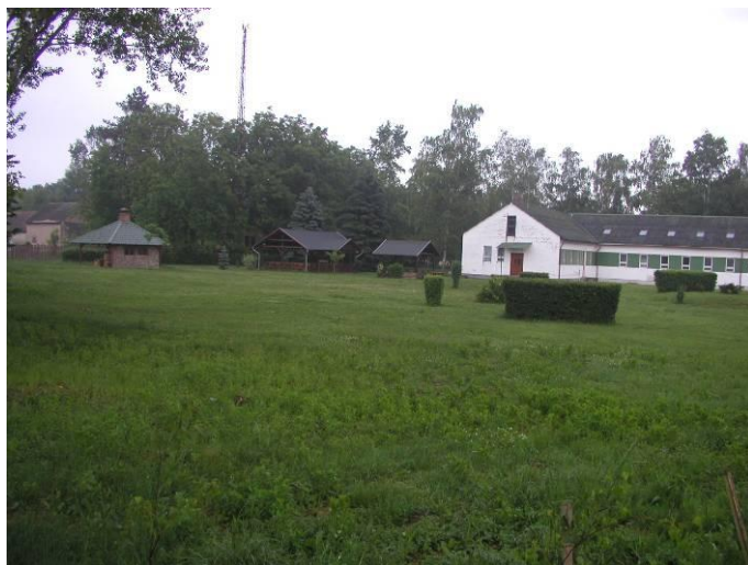
Az erdei iskola épülete és környezete
