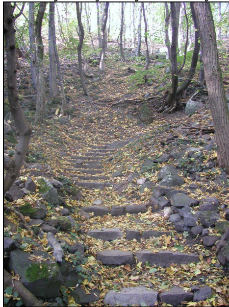
Bazaltból épített ösvény a Klastrom-kút közelében
